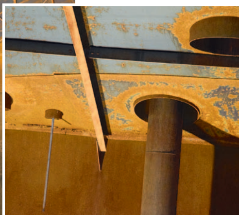
Detailaufnahme eines der festgelegten und entsprechend markierten Prüfpunkte.
